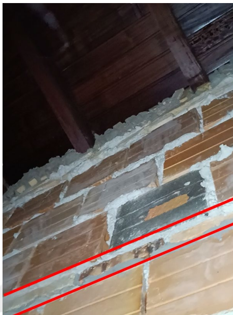
Fotografía 12. Apoyo de tirante en mampostería 5
