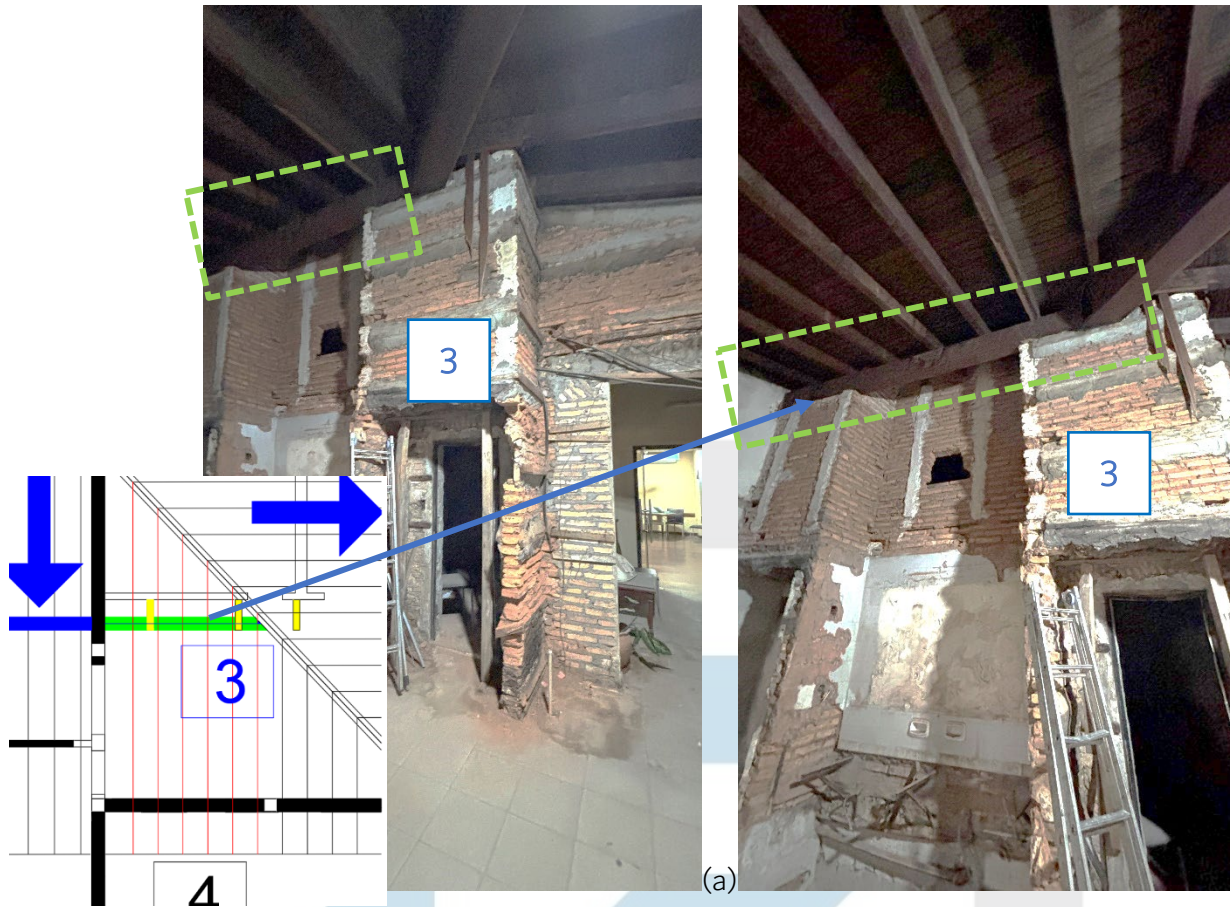
Fotografía 8. Vista de la mampostería "3"
