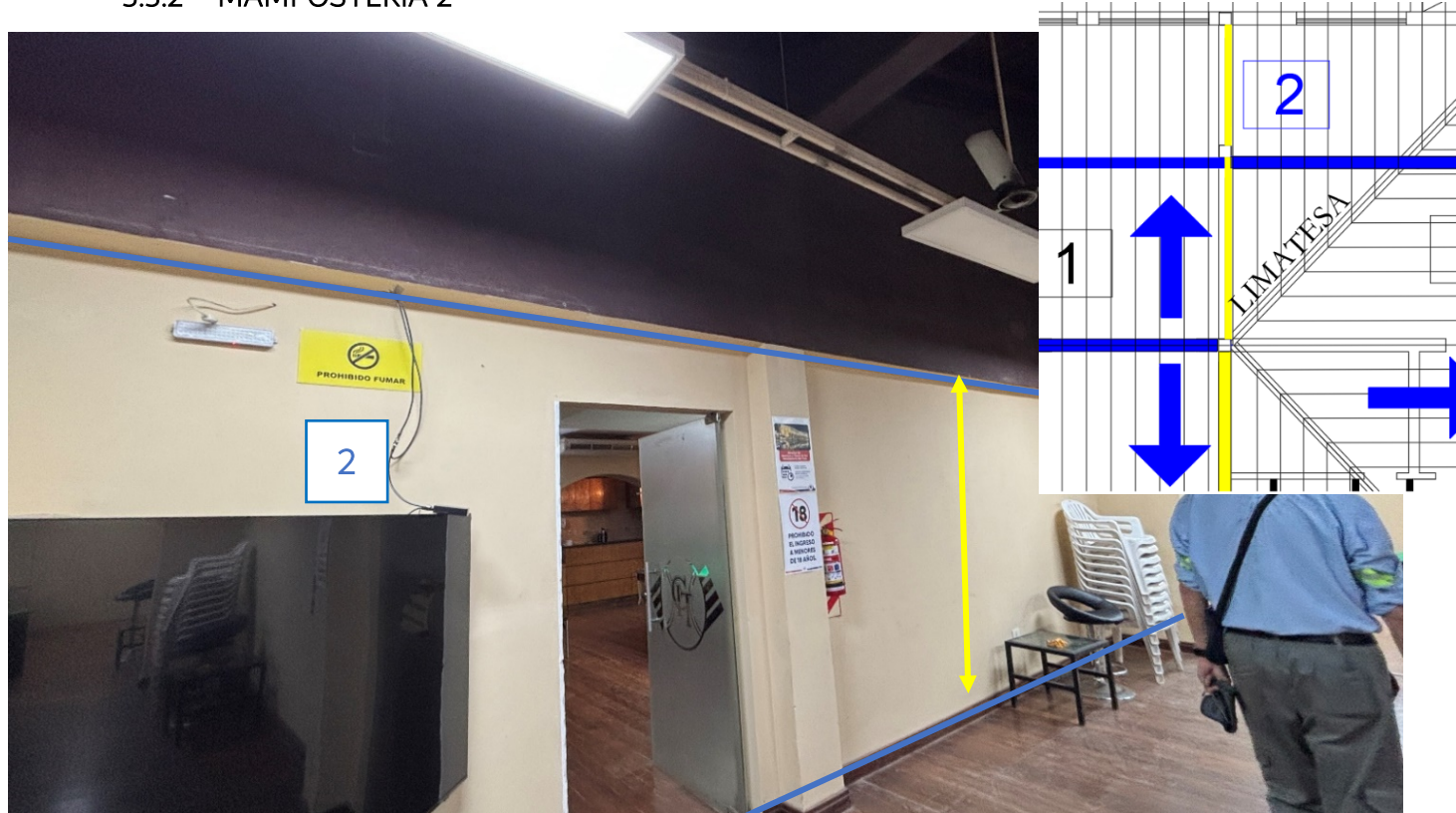
Fotografía 4. Vista de la mampostería "2"
