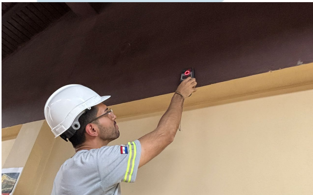
Fotografía 2. Ejecución de ensayo de pachometría, para detección de armaduras
