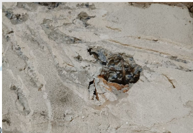
Fotografía 7. Armaduras expuestas (a) En pilar (b) En viga
