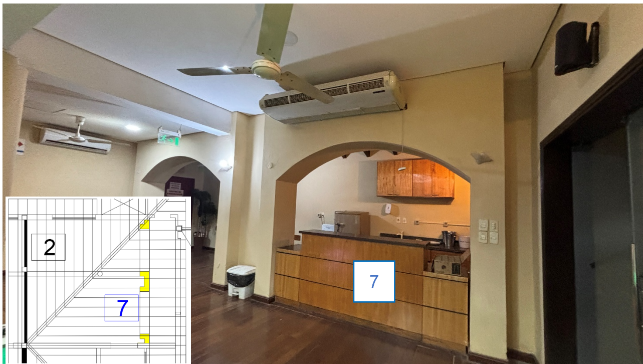
Fotografía 14. Vista de la mampostería "7"
