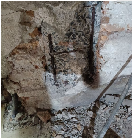
Fotografía 7. Armaduras expuestas (a) En pilar (b) En viga
