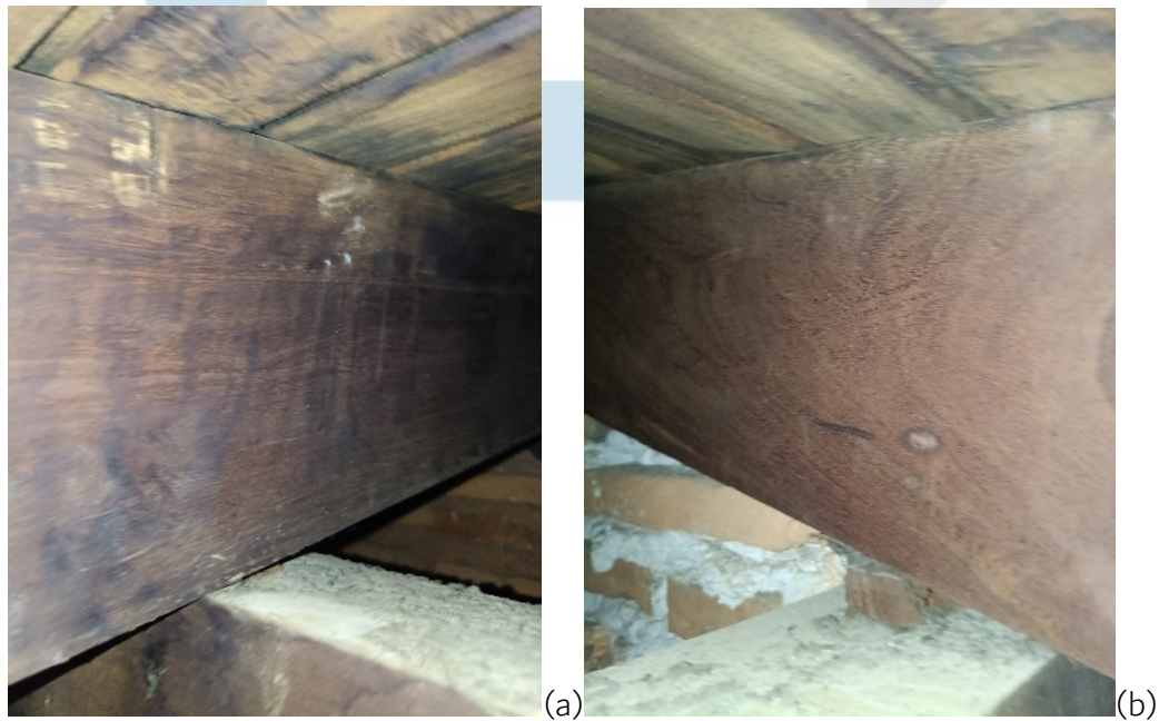
Fotografía 9. Inspección de apoyo de tirantes
