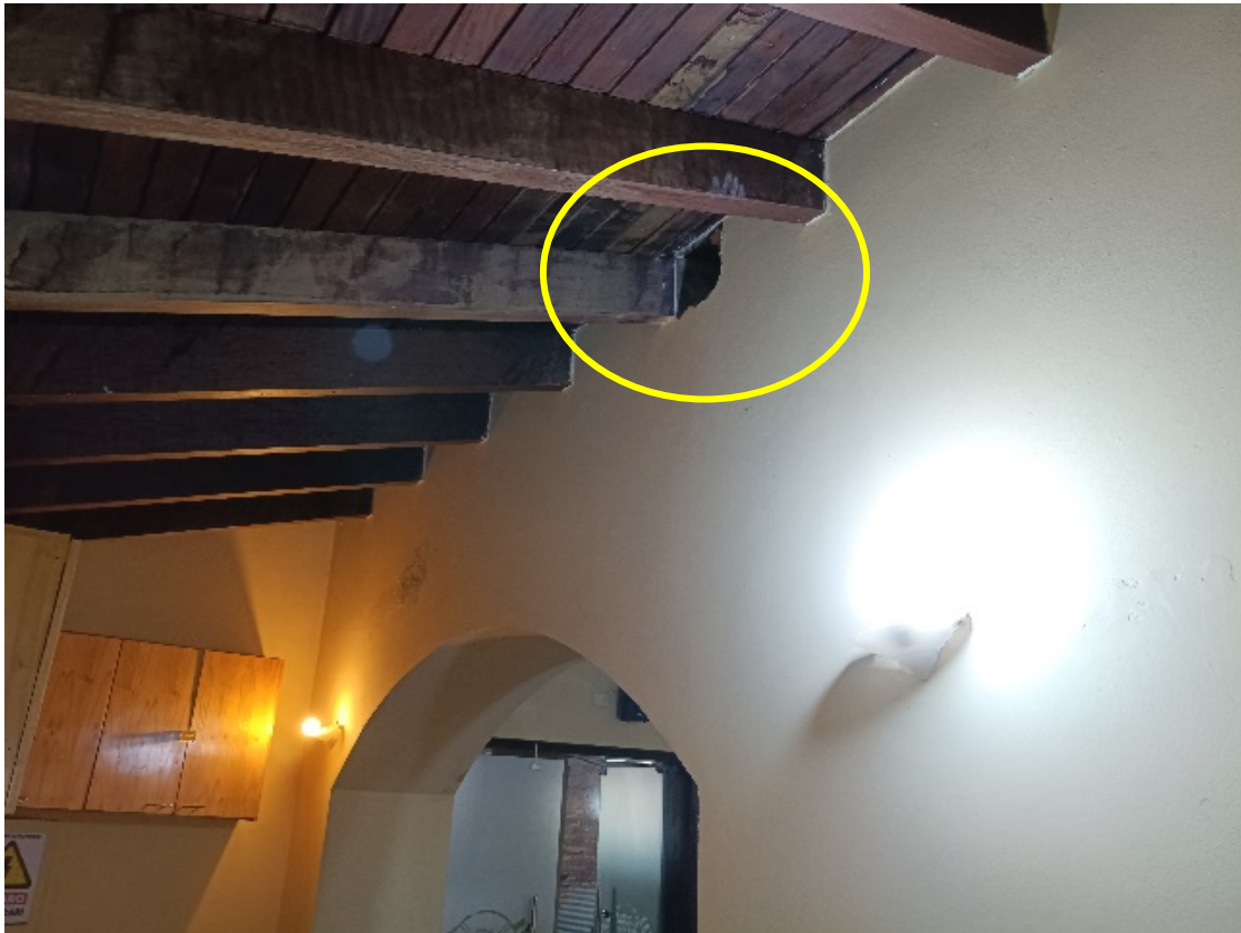
Fotografía 16. Inspección de continuidad de tirantes
